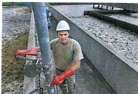
Opérateur usines assainissement en opération de maintenance
